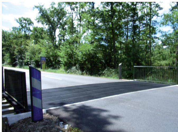
Les grilles empêchent le gibier de passer aux entrées du domaine et du village.
